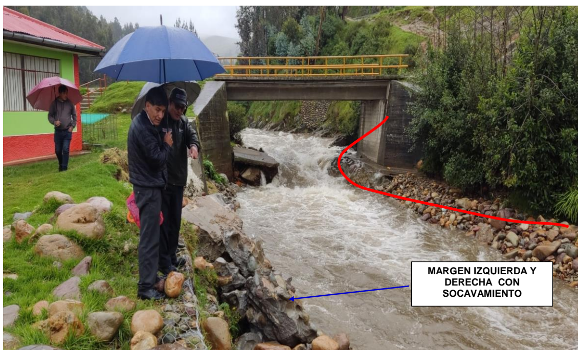
.FIGURA N° 02: RIO MASMA CHICCHE SOCAVAMIENTO DE PUENTE CONCRETO, CERCA A LA I.E.I
