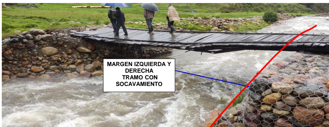
FIGURA N°03: EN LA TEMPORADA DE INICIO DE INCREMENTO DE AVENIDAS, EN EL RIO MASMA CHICCHE EROSION EN AMBAS
